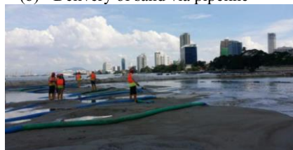
(d) Spreading of sand on weak soil seabed
